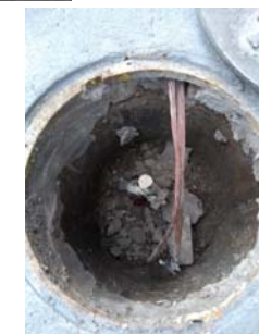
Novo anel de aterramento, e caixas de inspeção
