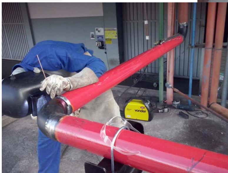
Fabricação e soldagem das tubulações DN 4''
