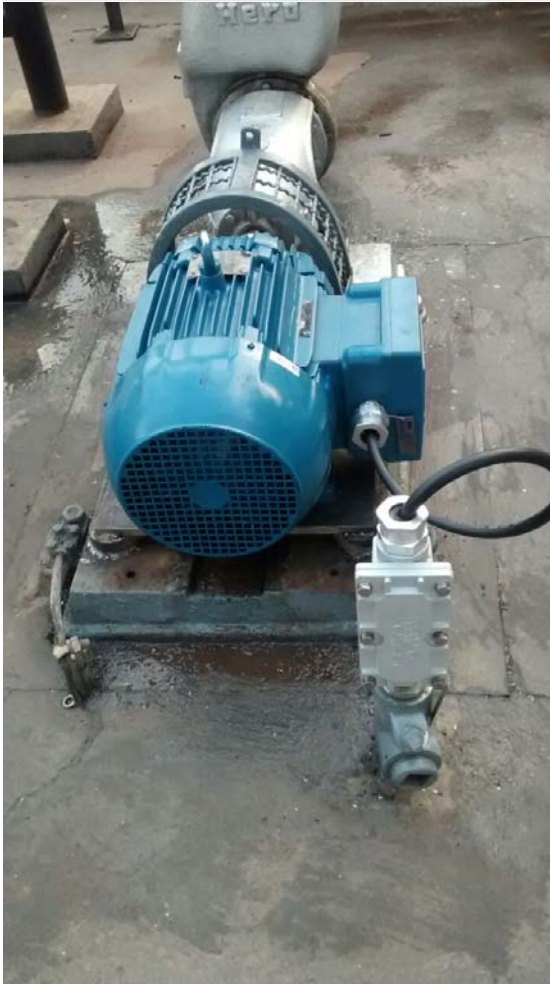
Adaptação motor e instalação APEX
