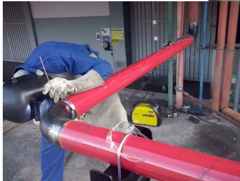
Fabricação e soldagem das tubulações DN 4''
