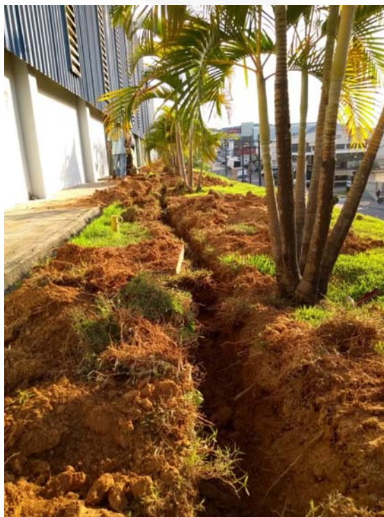
Escavação para novo anel equipotencial de aterramento
