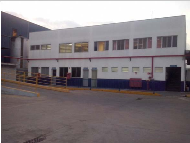
Nova Rede de água pelo refeitório
