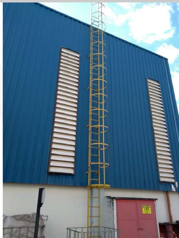
Trabalho em altura para novos captadores de surtos
