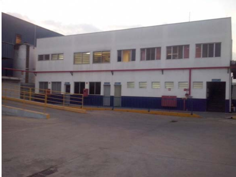
Nova Rede de água pelo refeitório
